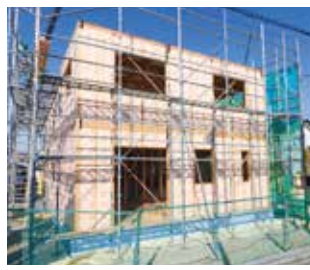
まず強固な六面体を作り、その上に屋根を乗せる構造。
