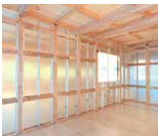
筋交いのないすっきりした壁面構造。
